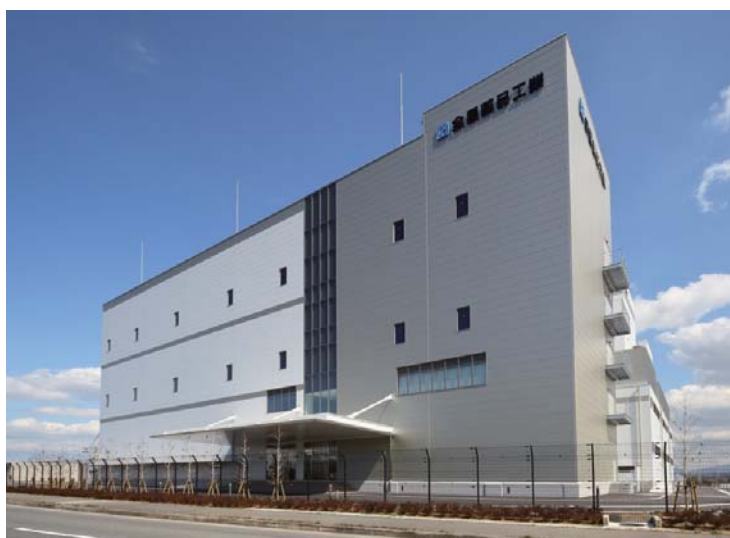
▲全星薬品工業 和泉工場外観
