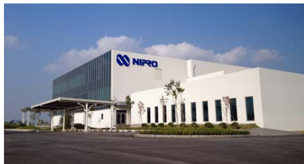
▲ベトナム工場外観
