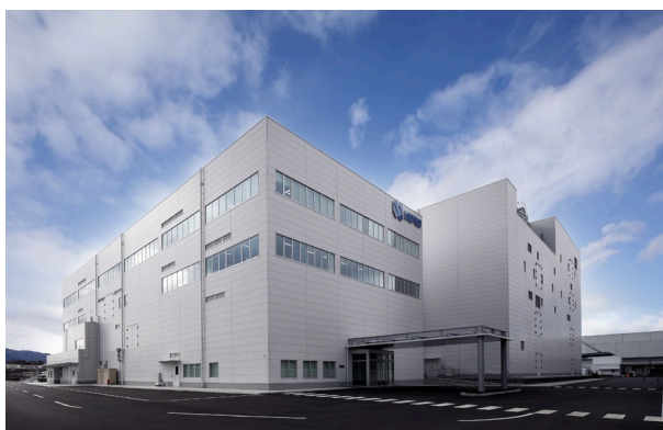
▲近江工場 一般注射剤棟 (バイアル棟)
