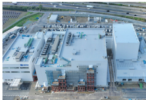
建設中のバイアル製造棟
