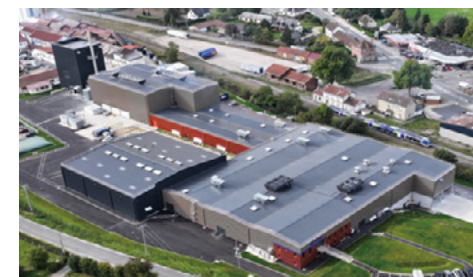
オマール工場 新ガラス管製造棟
