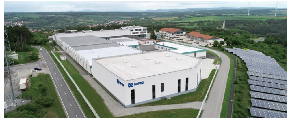
シリンジ製造棟の全景
